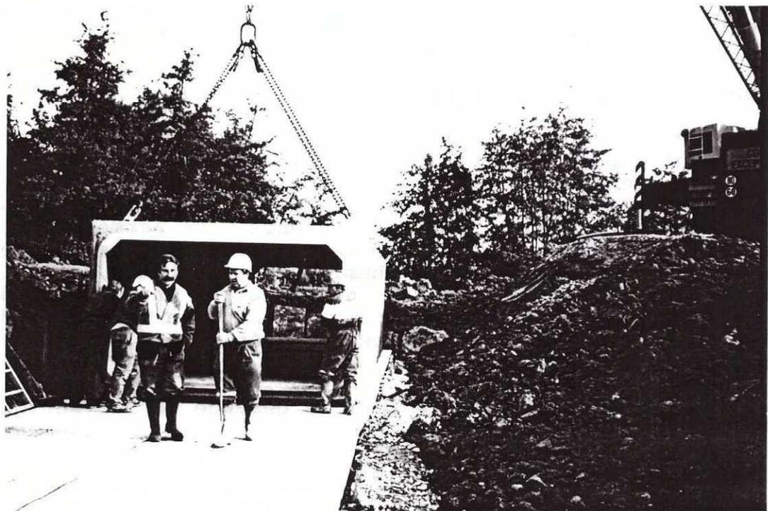
Après avoir aménagé le carrefour à angle droit supprimant l'Y existant à la hauteur du creux de BRUHANT, une tranchée de 6m de large et 2.80m de profondeur fut creusée en travers de la voie communale. Problème de grue, au moins 120 tonnes - problème E.D.F. avec la ligne moyenne tension et distance de sécurité à observer d'au moins 3m pour tous travaux, d'où coupure de courant à programmer plusieurs jours à l'avance.
